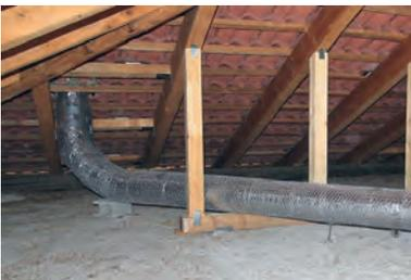
Innen wird die warme Luft möglichst direkt in den Raum eingeblasen. Um an eine geeignete Stelle zu gelangen, können 3–5 m Schlauchleitung verlegt werden.
